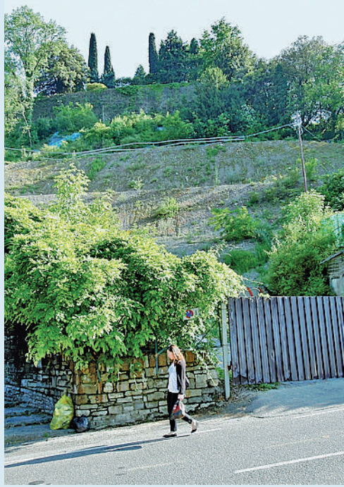
Il cantiere. Lavori fermi dal 2008 in via Fara
